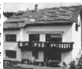
Haus mit Solarthermie und Photovoltaik
