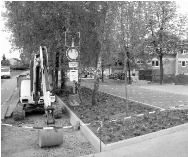
Parkplätze am Berkacher Weg: Baustelle in vollem Gang
