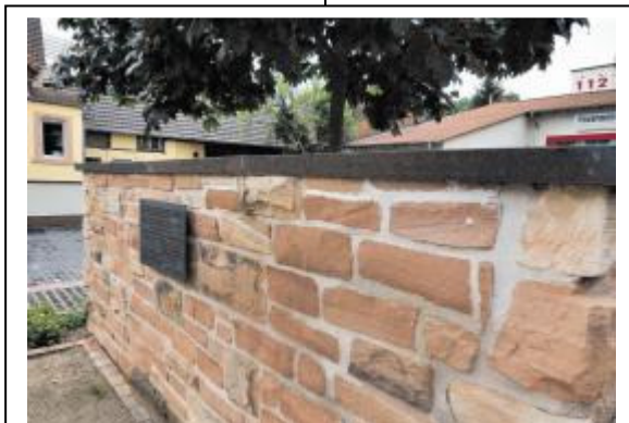
Eine Bruchsteinmauer, in die Sockelsteine des alten Gebäudes eingearbeitet sind, ist die einzige Erinnerung an das Klein-Gerauer Gottschall-Haus, das Anfang 2000 abgerissen wurde.
