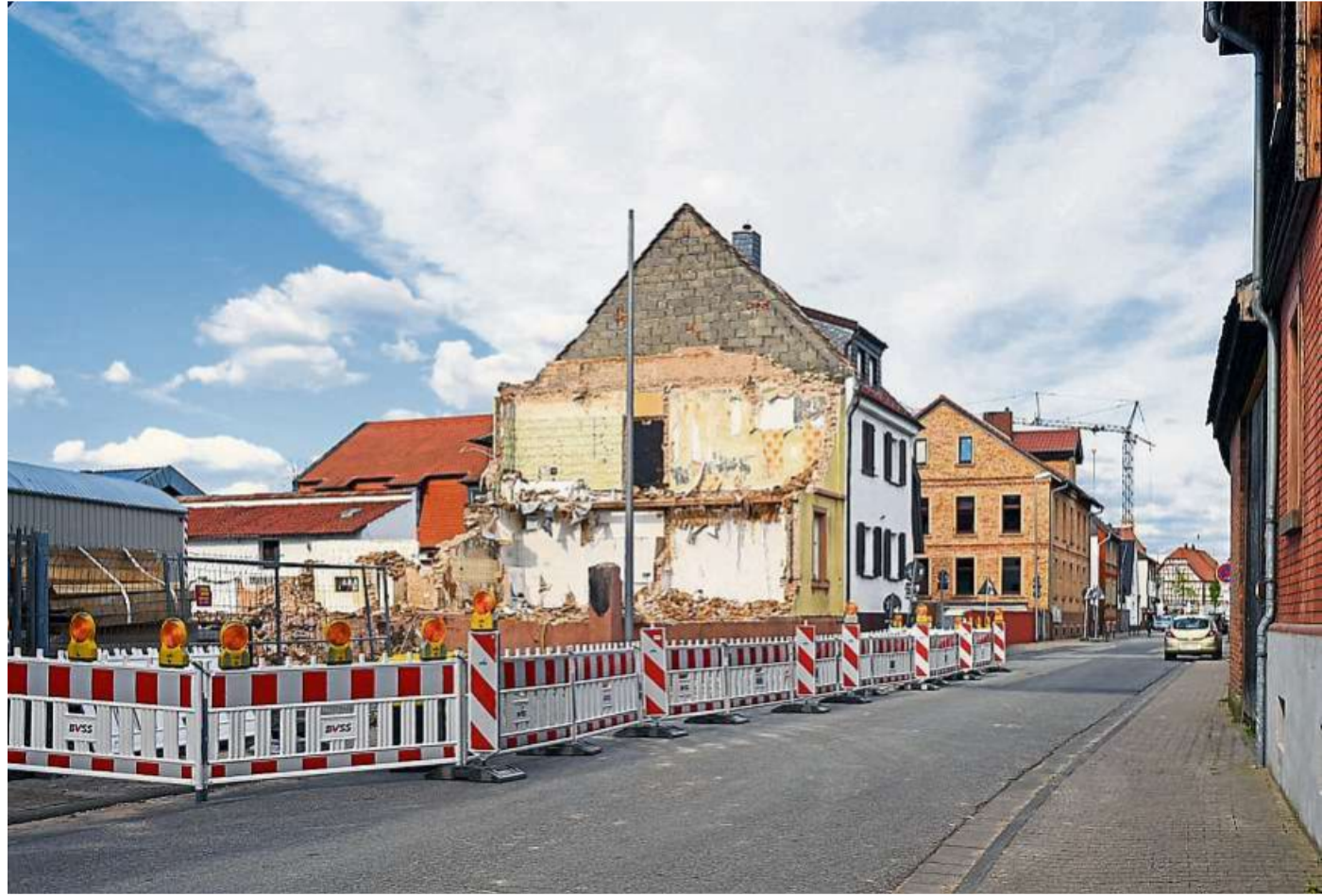
Eine rege Bautätigkeit ist im alten Worfelder Ortskern zu sehen.
