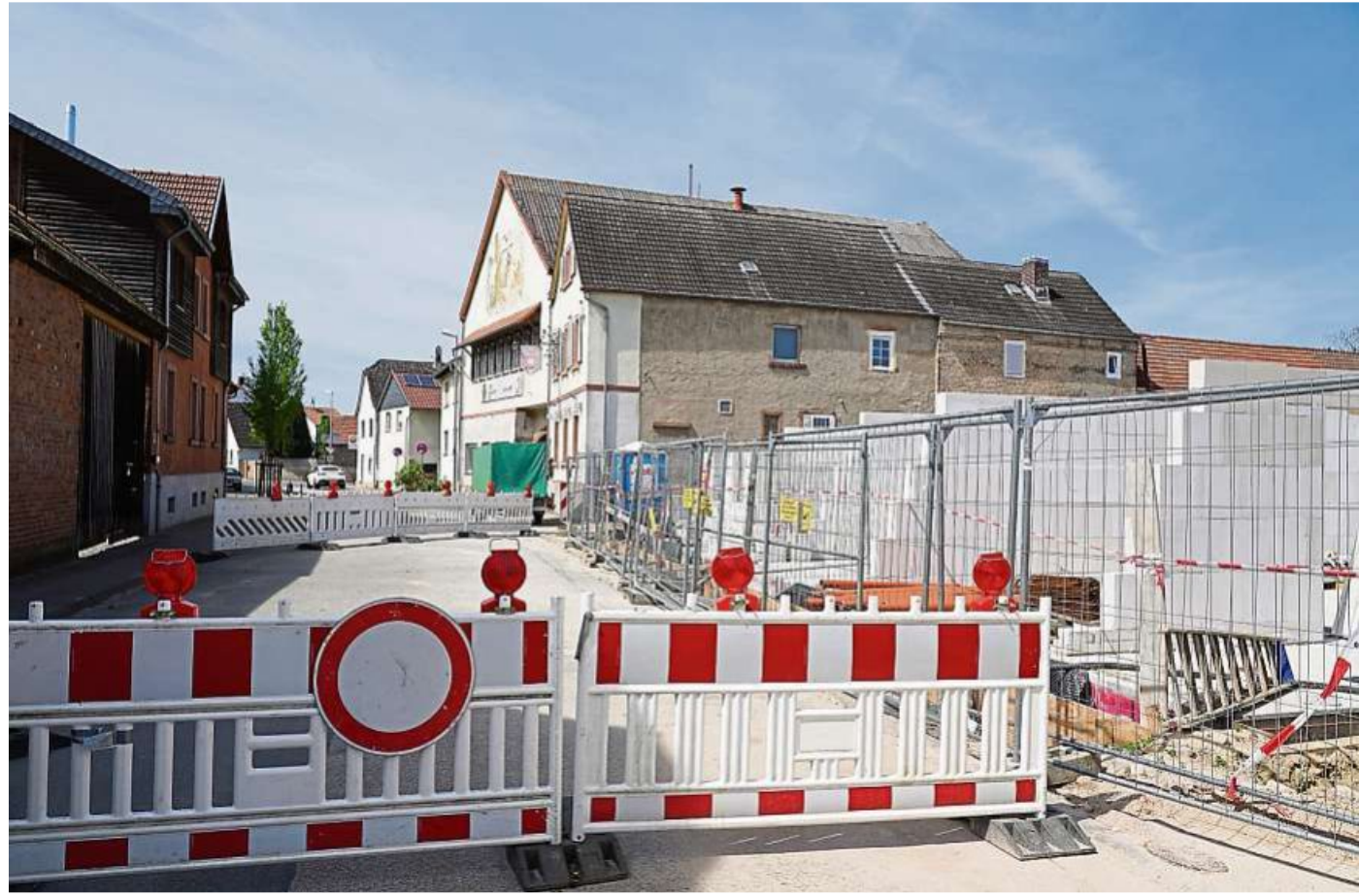
Noch immer gesperrt ist die Straße Unterdorf in Worfelden. Bei einem Bauprojekt im Ortskern geht es nicht voran. Foto: Marc Schüller
